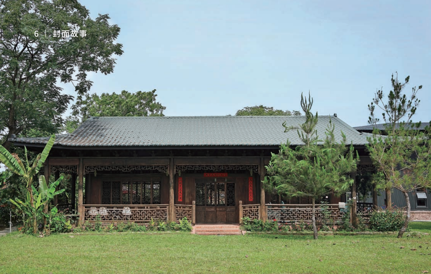
雕工細緻的「吉祥居」是一棟集結志工力量，將回收建材重新拼合的木造建築，目前作為書室使用。
